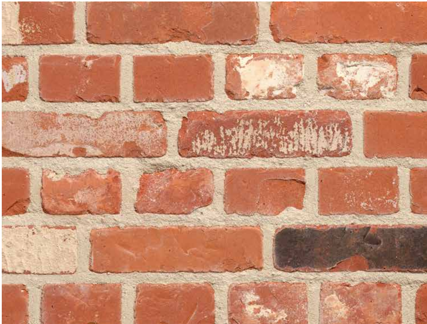
Schijnvoeg / Faux joint
